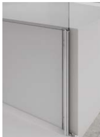
Détail support avant avec fermeture magnétique pour paroi fixe raccourcie
