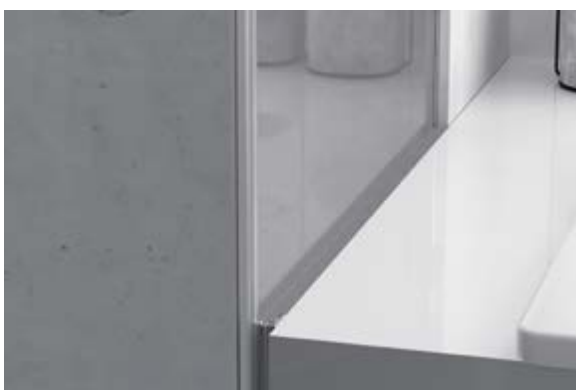
La paroi fixe raccourcie est systématiquement posée à côté du muret
